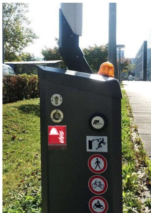
Figur 6.2 viser eksempel på elektrisk aktivering med trekant
