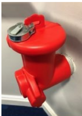
Figur 9.1 viser en aflåsning løsning hvor man sætter en kappe udenom ventil og kobling som så kan aflåses med en hængelås.
