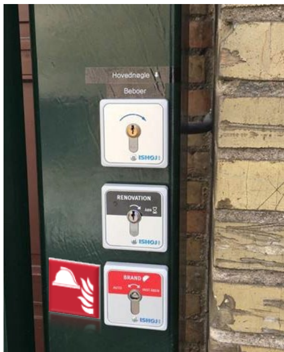
Figur 6.1 viser eksempel på elektrisk aktivering med Cybertrekant.
